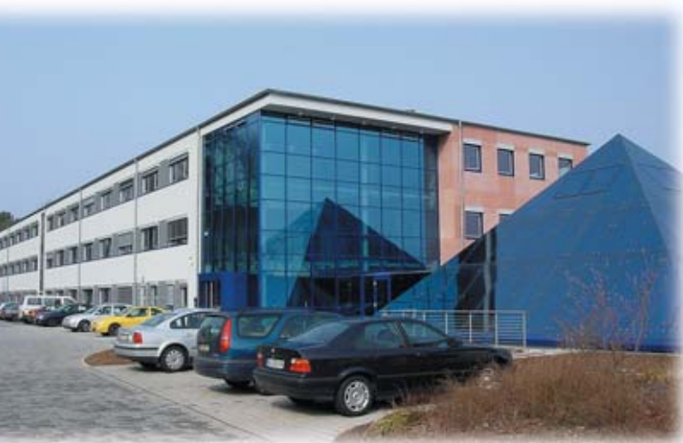
Der Hauptsitz der proALPHA Software AG in Weilerbach
